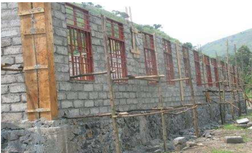
Chantier EP Sake : FACADE posterieure DU BLOC 1 DE 3 SdC/Masisi
